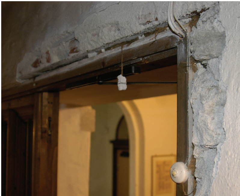
NEDSLITT: Murpussen på veggen er begynt å falle ned inne i kirkerommet.
