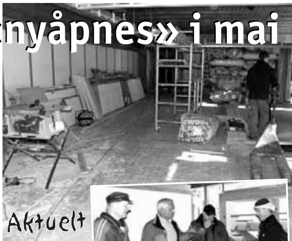
Menighetssalen er fremdeles byggeplass. Prosjektleder Magnar Tysseland og arkitekt Helge Hjertholm diskuterer praktiske løsninger med bygningsfolkene.
