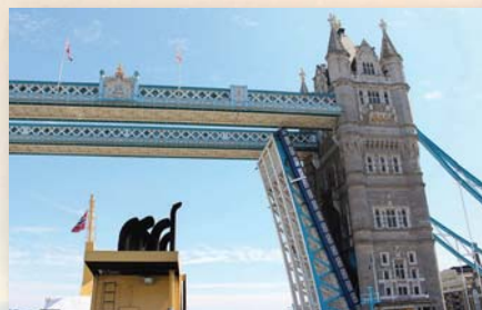
UNDER: TOWER BRIDGE: Selveste Tower Bridge (under) løftet seg for å slippe sjømannskirken frem.
